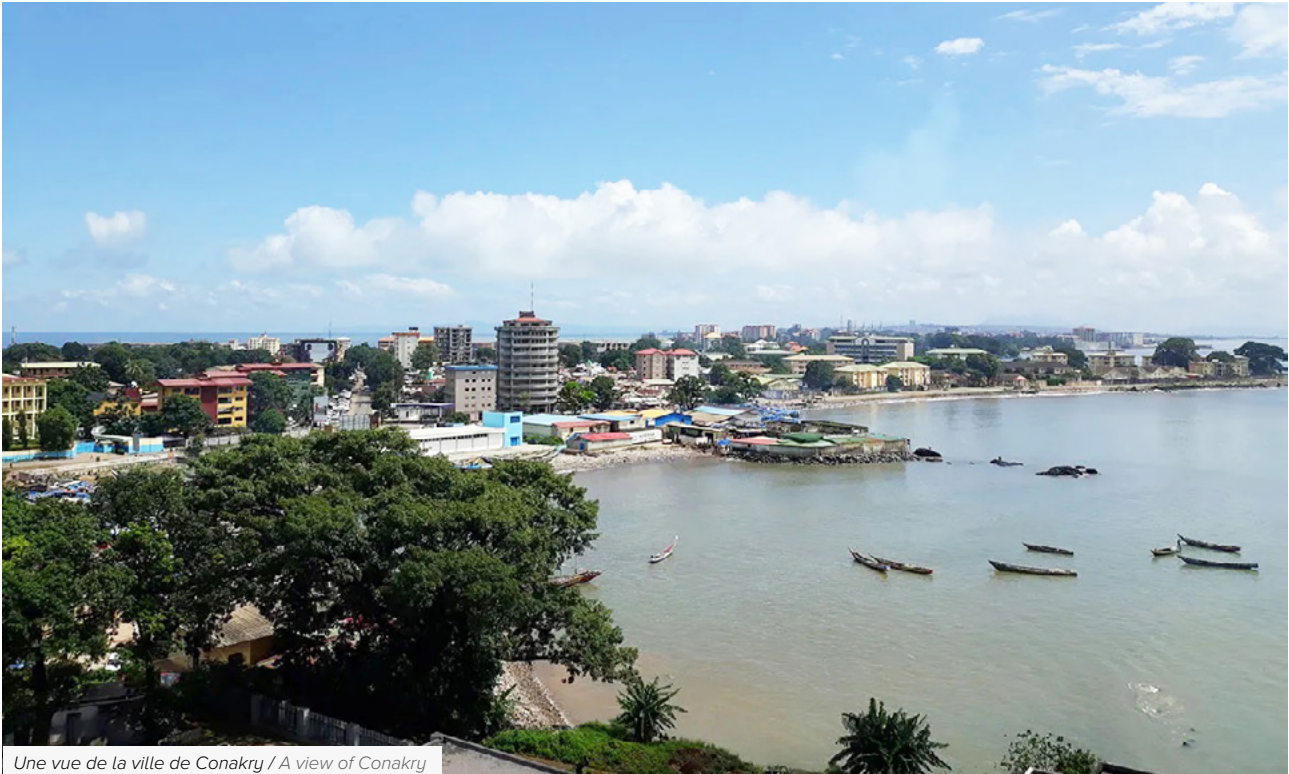
Une vue de la ville de Conakry / A view of Conakry
