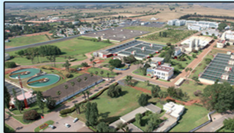
Station de Traitement des Eaux de Bouregreg - Rabat
