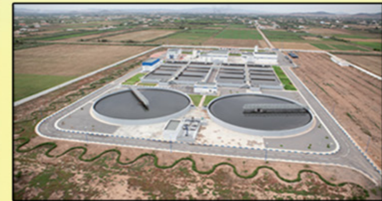
Station d'épuration des Eaux Usées - Grand Nador
