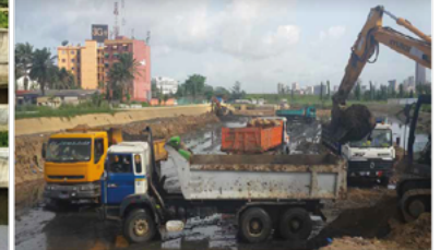
Entretien des ouvrages de drainage
