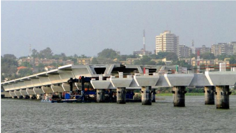
Travaux du 4 ème pont
