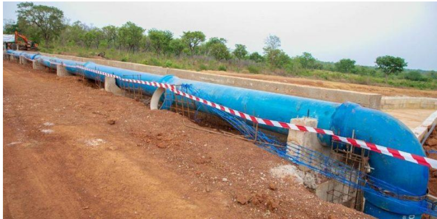
Travaux d'adduction en eau potable- 2024
