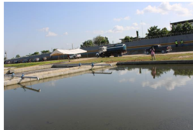
Les chantiers hydrauliques dans le Gbêkê
