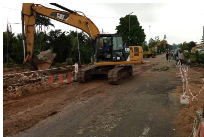
Travaux de drainage
