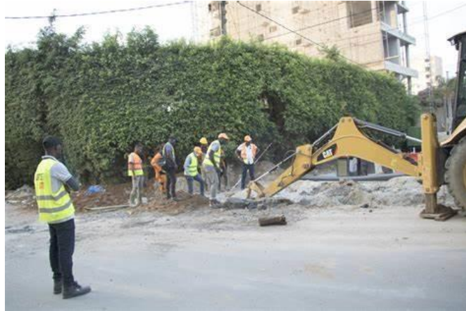
Travaux de déplacement du réseau dans le cadre de la construction du métro d'Abidjan
