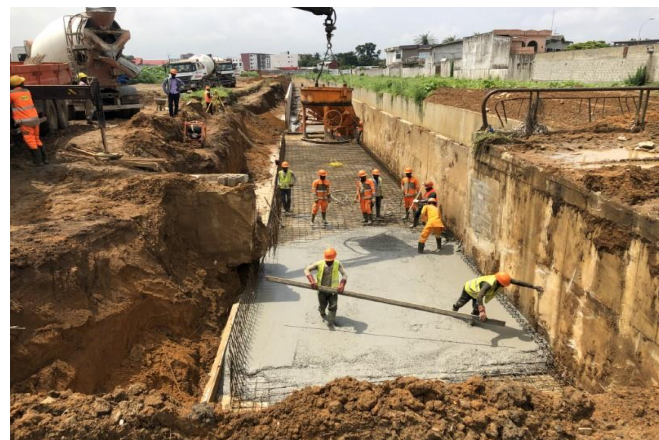
Construction d'un canal primaire a la riviera 9km
