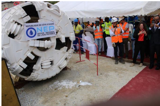
lancement des travaux de construction d'ouvrages de drainage des eaux pluviales le 16 août 2022 à Gesco (Yopougon)
