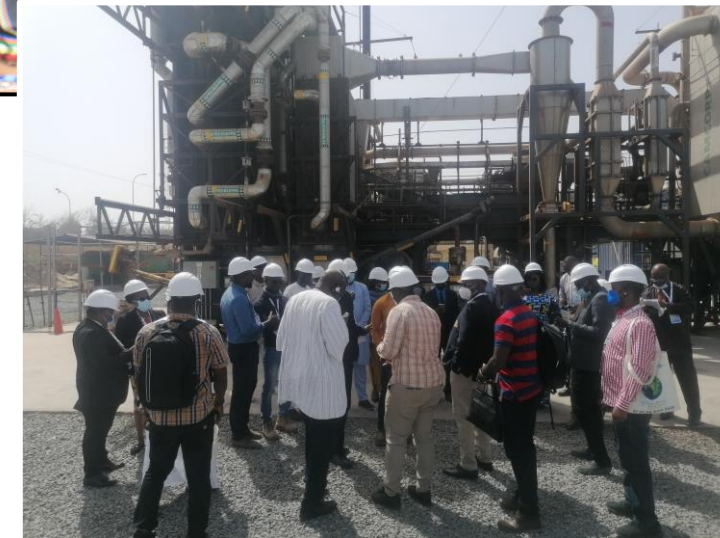
Photo 7: Visite de Benchmarking des maires sur le CWIS au FME 9
