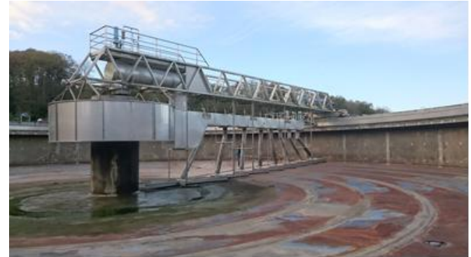
Ville de LAVAL – Pont racleur de clarificateur (53)
