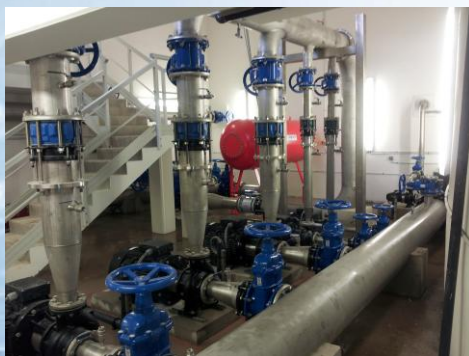
Construction d'un réservoir au sol de 2000 m 3 et ouvrages associés Commune de ST BREVIN LES PINS
