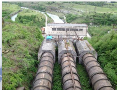
Centrale hydroélectrique de Vardnili, Géorgie
