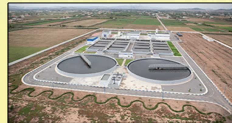
Station d'épuration des Eaux Usées - Grand Nador
