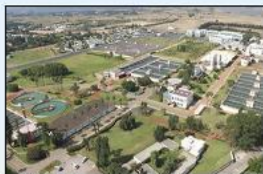
Station de Traitement des Eaux de Bouregreg - Rabat
