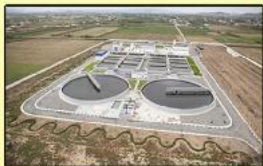
Station d'épuration des Eaux Usées - Grand Nadir
